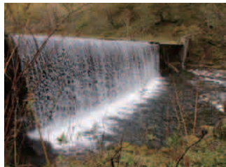
▲第1号 鋼製ダム
